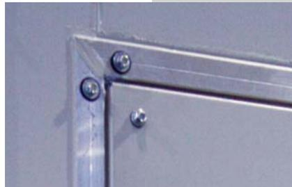
**Sheet metal door frame**, not thermal broken.
